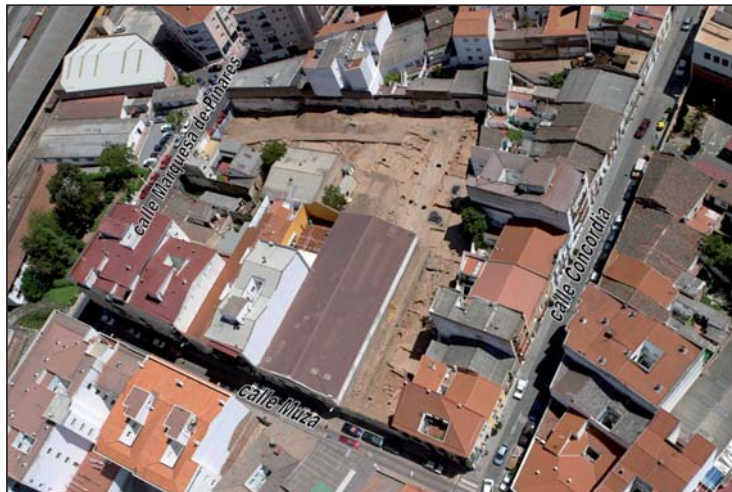
SITUACIÓN DEL SOLAR (Fotografía de J. Rueda, 2005)
